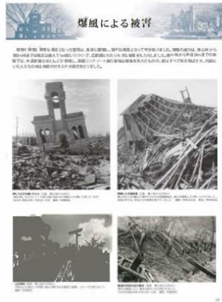
17 爆風による被害 Damage from Blast
